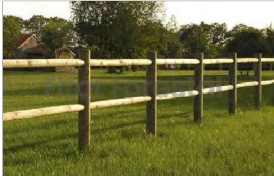
COLOCACIÓN TALANQUERA DOBLE
